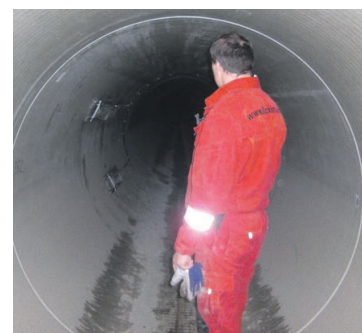
In mehreren Meter hohen Rohren arbeiten die Techniker.
